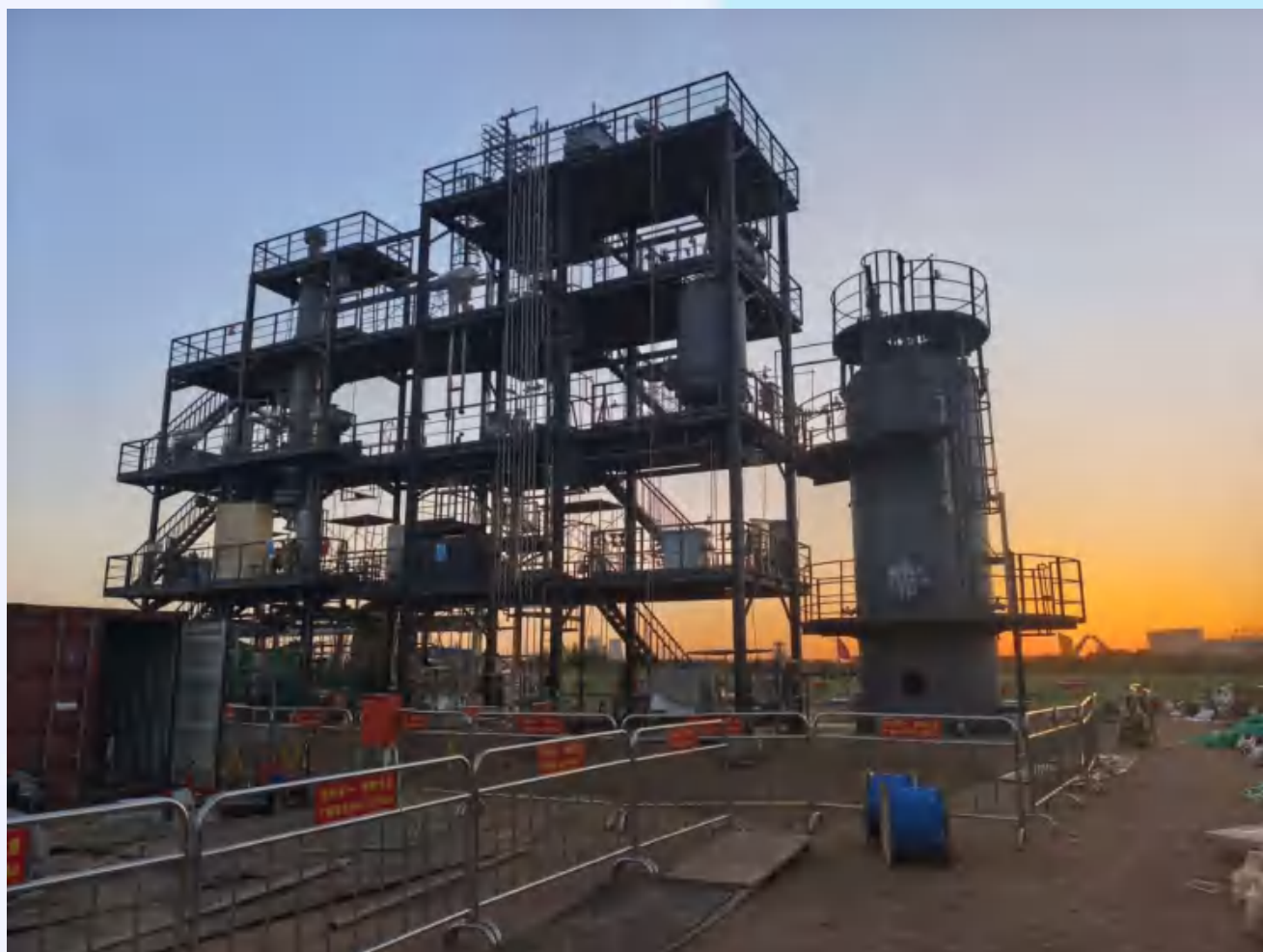
河北都邦石化工程设计有限公司总包项目施工中
