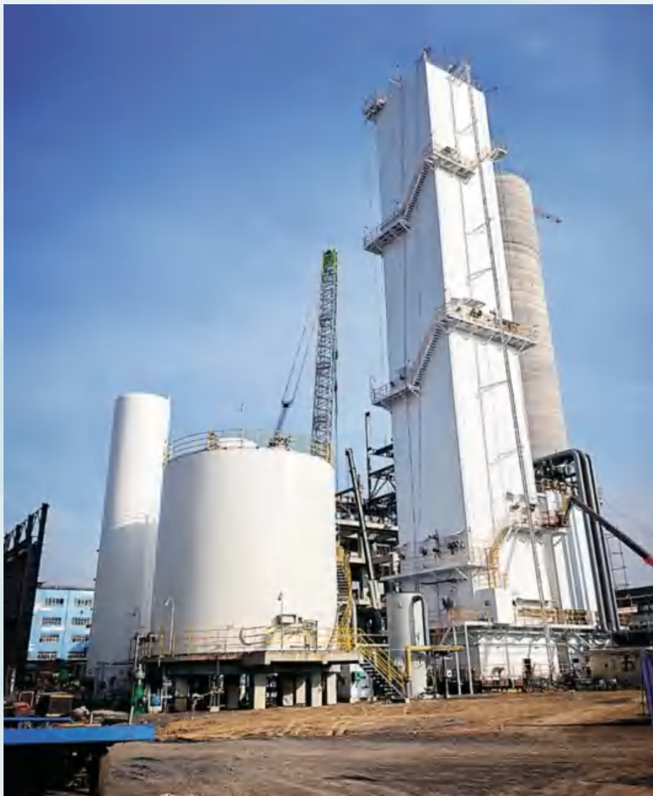
企业产业升级综合利用（一期）气化改造项目施工现场。侯文娟 摄
