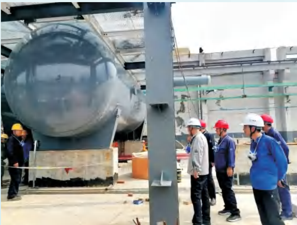
▲总经理张广果检查工程进展和安全施工情况
