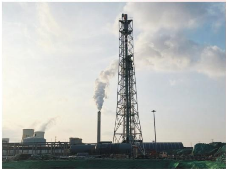
这座火炬塔架总高约69.5米，是项目的重要组成部分。
